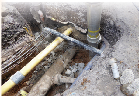
Schonendes und beschädigungsfreies Freilegen von Erdreich.
